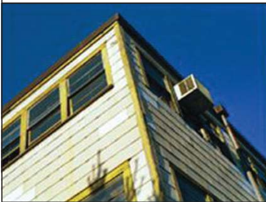
تصویر ۶. ساختمان شماره‌ی ۲۰، جزئیات پنجره، سال ۱۹۹۷
